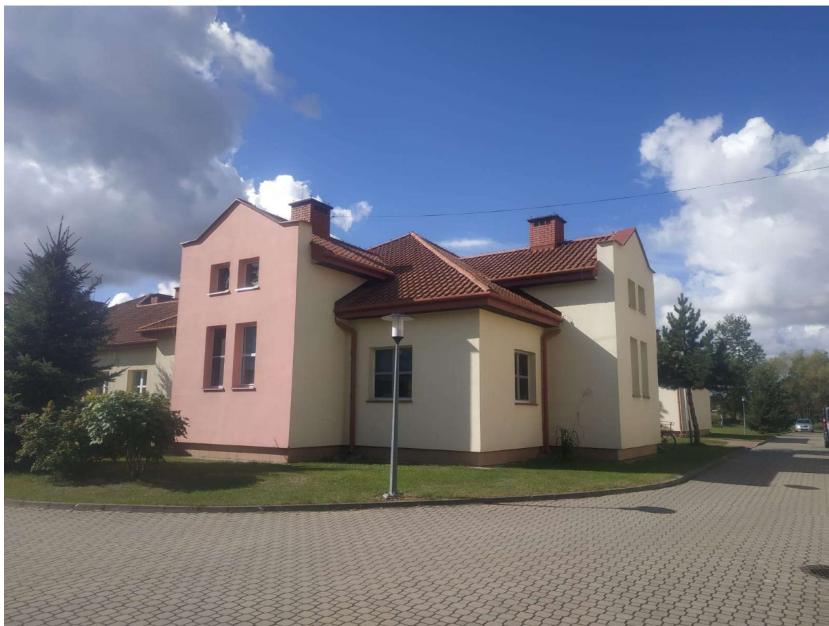
Fot. 3 Widok od strony północno-wschodniej
