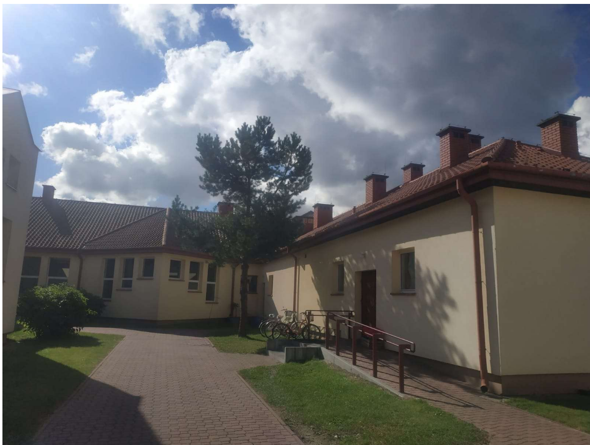
Fot. 4 Widok od strony północnej
