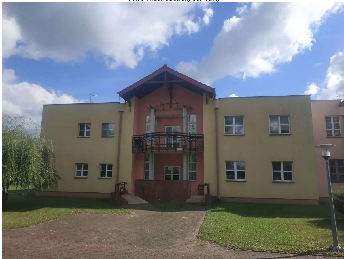
Fot. 9 Widok od strony zachodniej
