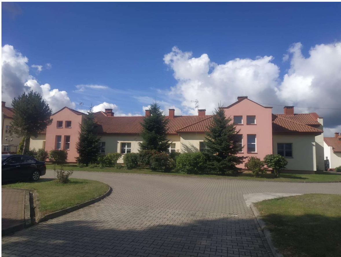
Fot. 2 Widok od strony wschodniej
