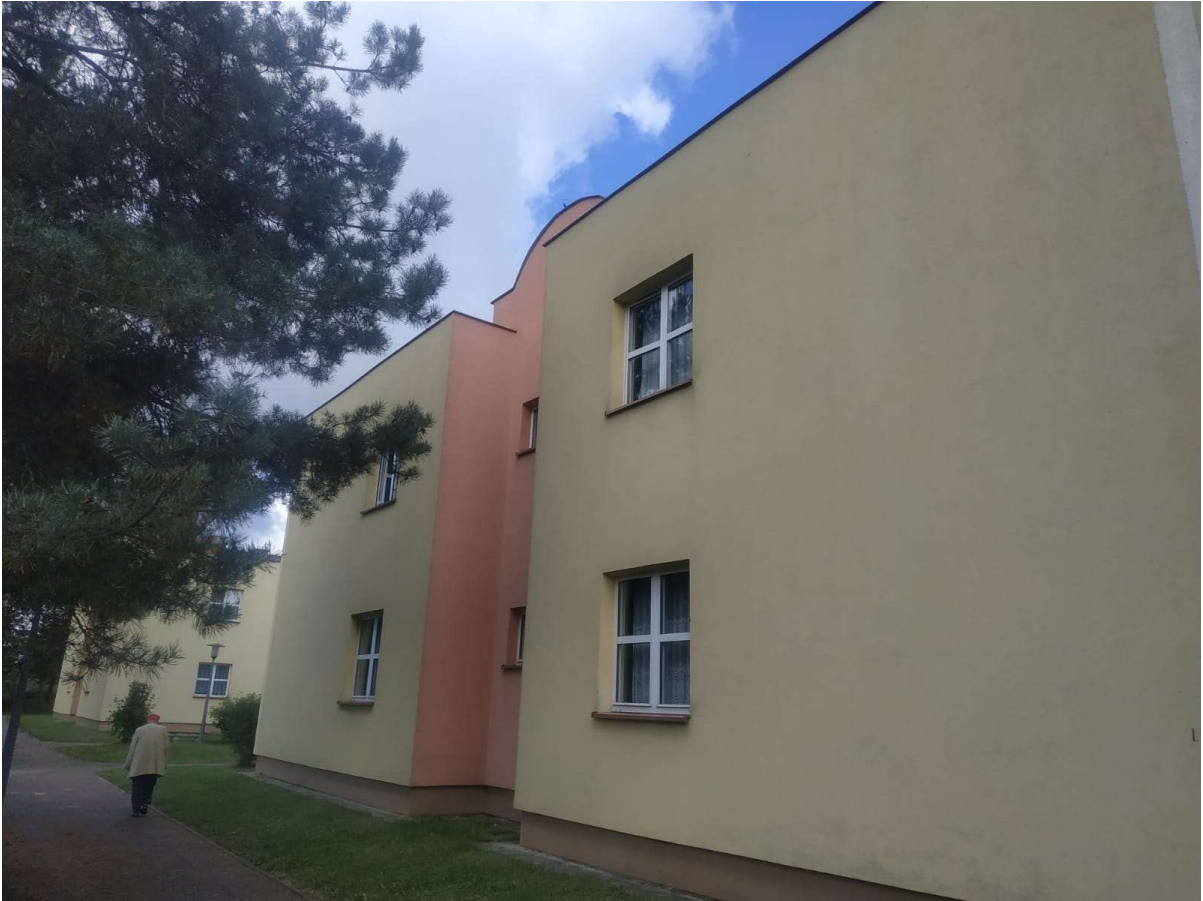
Fot. 14 Widok od strony południowo wschodniej
