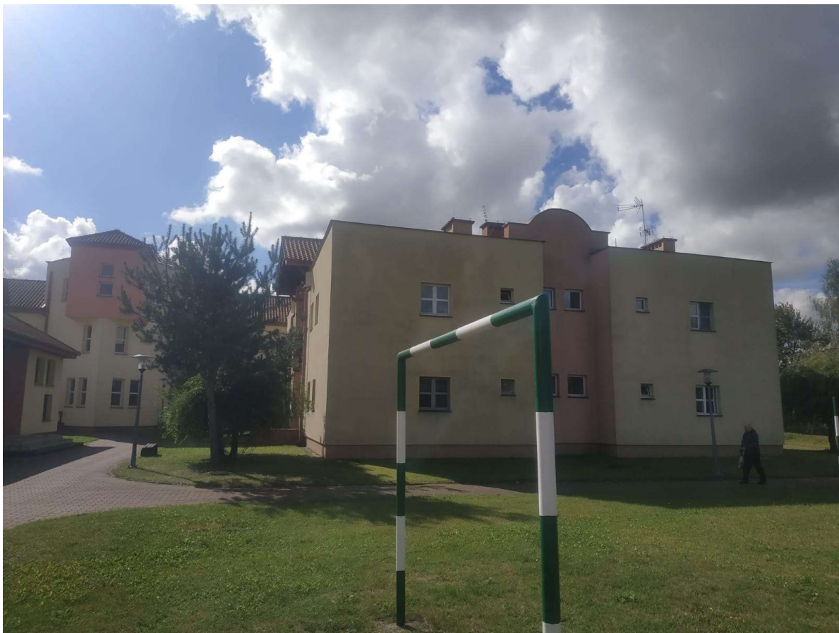
Fot. 8 Widok od strony północnej
