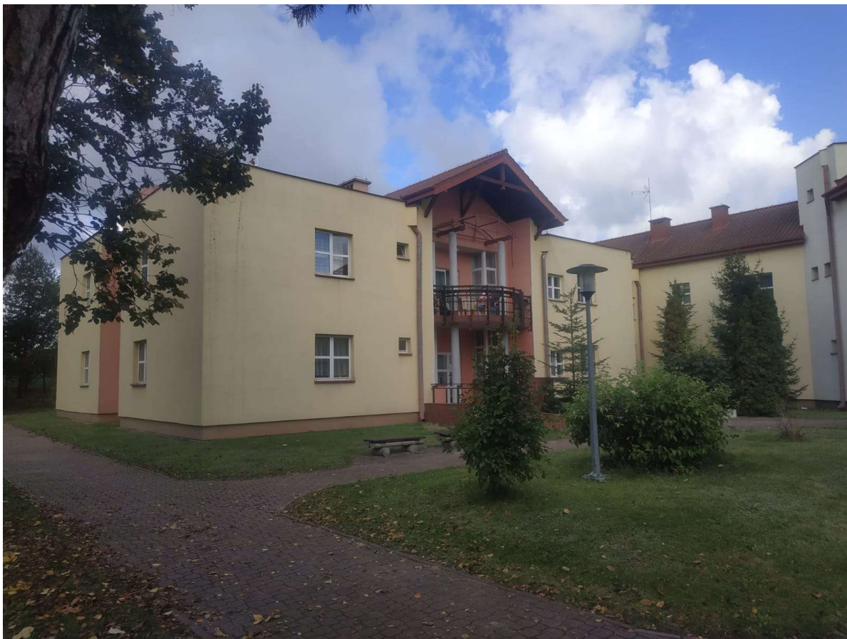
Fot. 12 Widok od strony południowo-wschodniej
