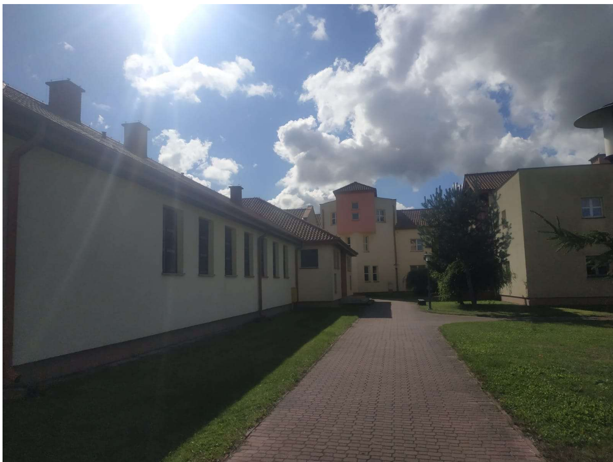
Fot. 6 Widok od strony północnej
